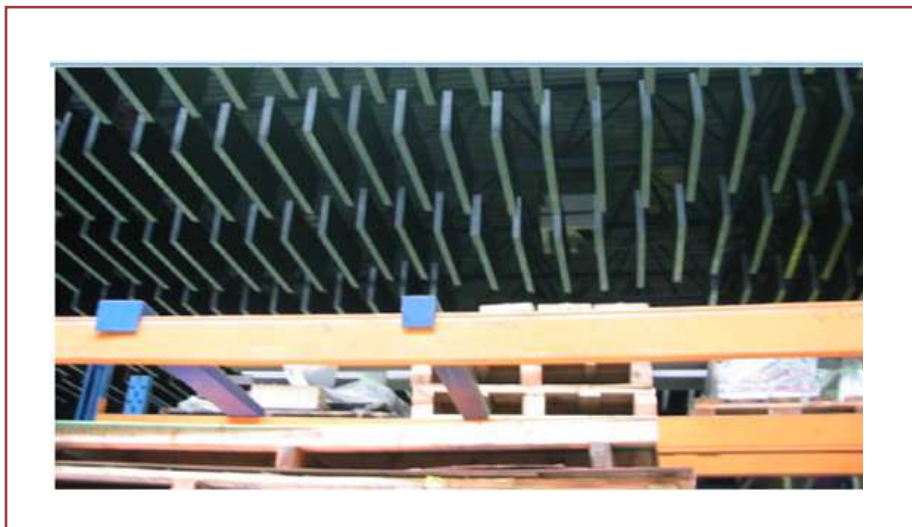
شکل ۵۴- استفاده از جاذب های صوتی جهت کاهش صدا در محیط کار
